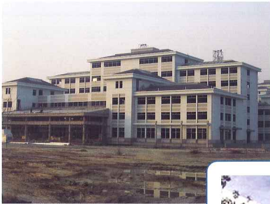
杭州富阳中医骨伤科医院
